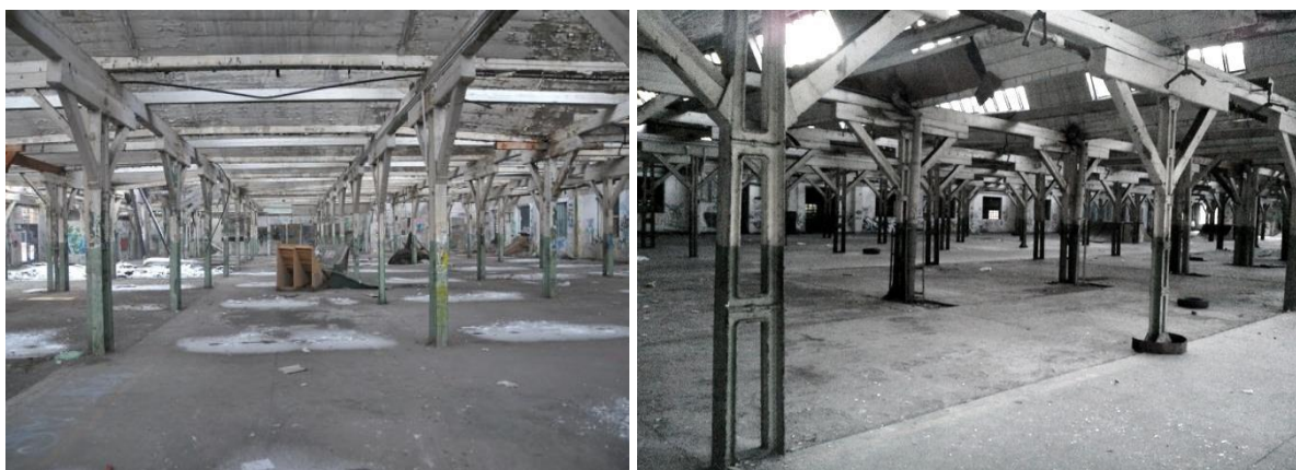
Slika 32. Izgled unutrašnjosti objekta Mašinsko/mehaničke radionice
