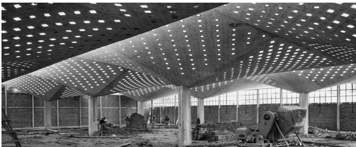
Slika 23. Feliks Kandela 61 , izgradnja objekta ( Palacio de los Deportes ), Meksiko Siti, 1968.
