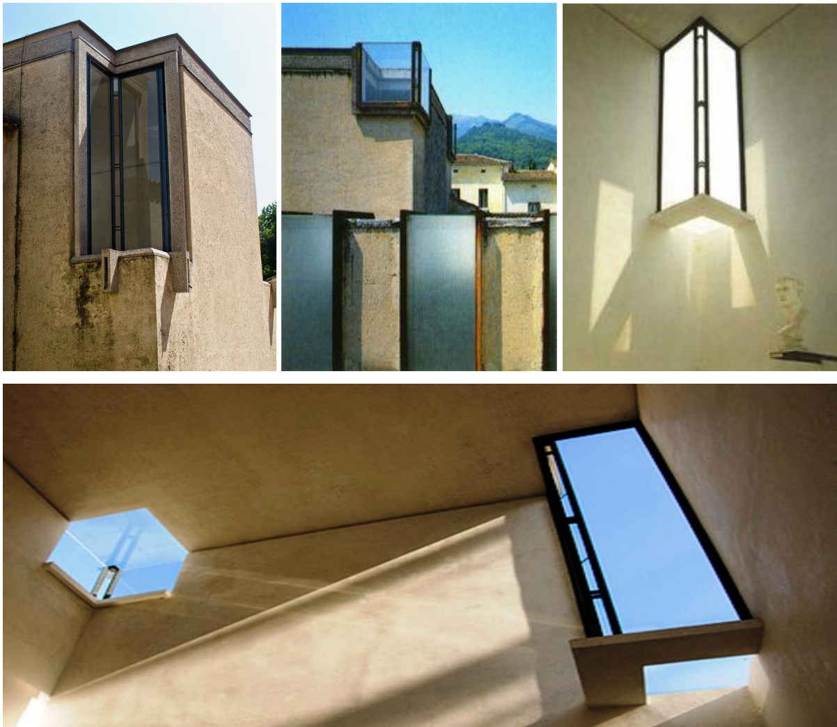
Slika 9. Karlo Scarpa, prozori zgrade Muzeja ( Gipsoteca Canoviana ), Treviso, 1957.
